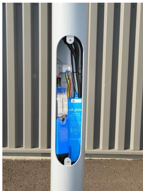
Coffret de mat et boîtier Citybox
